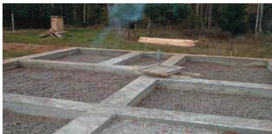
Мелкозаглубленный фундамент – то же, что и ленточный. Он располагается на небольшой глубине (выше глубины промерзания грунта). Мелкозаглубленная лента представляет собой армированную жесткую раму, размещаемую на песчаной подушке, которая равномерно поднимается и опускается вместе с постройкой при изменении состояния почвы (промерзание, таяние и т.п.). Подушка из песка равномерно распределяет пучинистые нагрузки.
